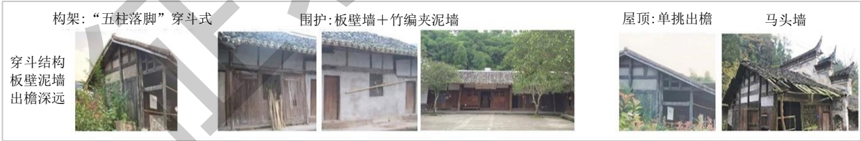
图18 适应气候，巧用地形，简朴实用的穿斗结构
